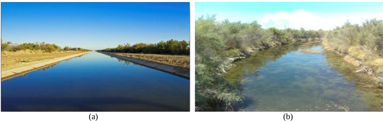
Figura 3. (a) canal Wellton-Mohawk, vista aguas arriba (SE-NW); (b) dren Riíto, vista aguas abajo (NW-SE).
