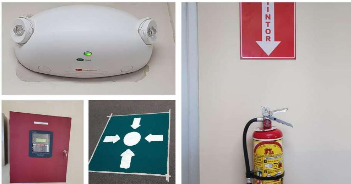
*Figura 65. Tablero FIRE-LITE, luces de emergencia y señalizaciones.*
